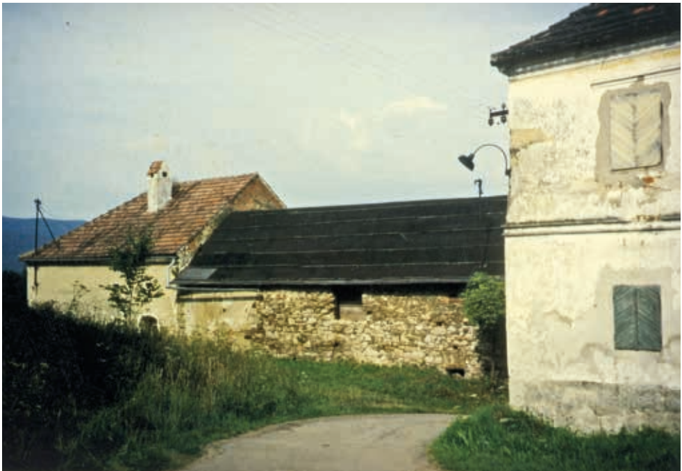
Obytná stavení v Přelsticích, po roce 1989. Fotografie zapůjčila Kateřina Nováková, rodinný archiv Zelmanových
