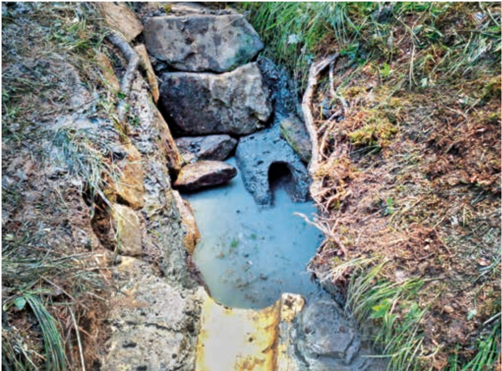
Boletický pramen č. 2 po vykopání starého dřevěného potrubí, foto Pavel Švancár, květen 2020
