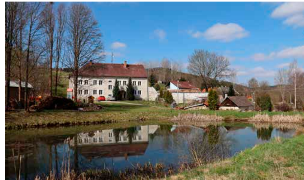
Zpevnění hráze rybníka v Mezipotočí, foto Josef Beňo.
