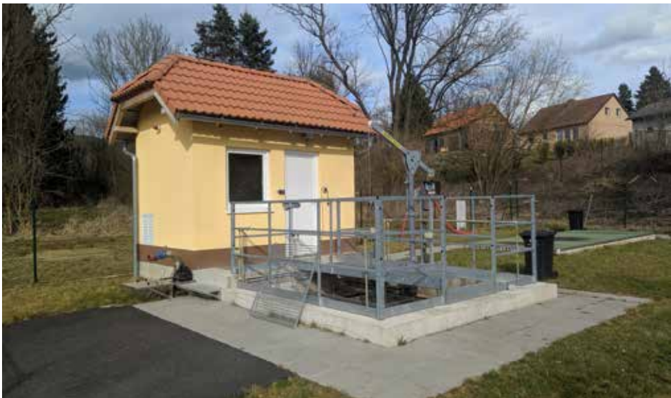
ČOV Křenov postavená v roce 2019. Foto Jiří Dvořáček
