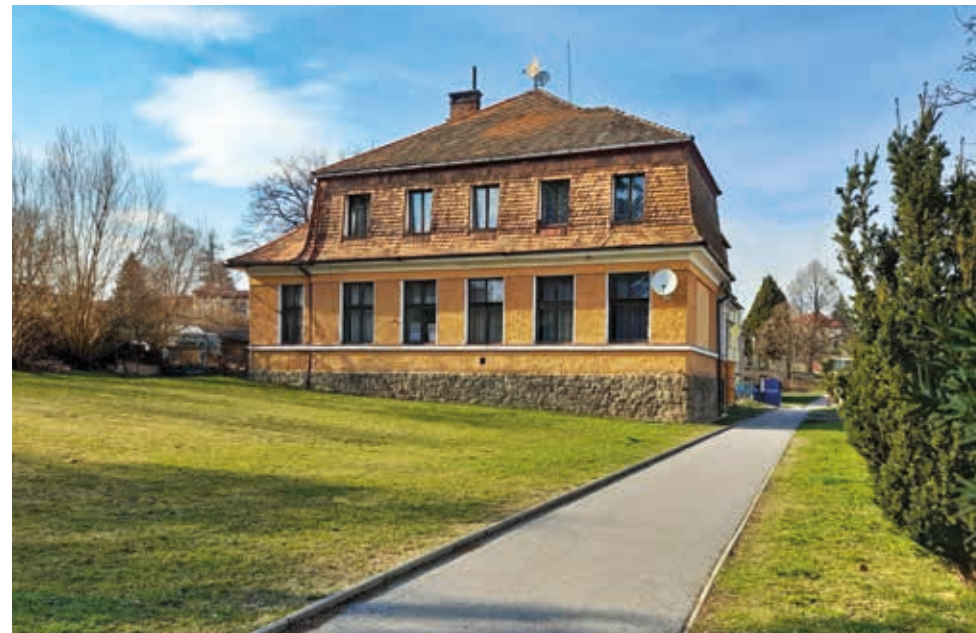
Nově zakoupená budova č.p. 8 (u autobusové zastávky), foto Jitka Radimská
