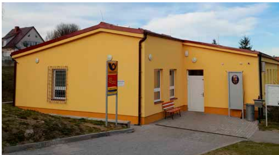
Rekonstrukce bývalé prodejny FLOP na Boletické č.p. 115, kde je nově pobočka České pošty, ordinace dětské lékařky a provizorně také obecní úřad.
