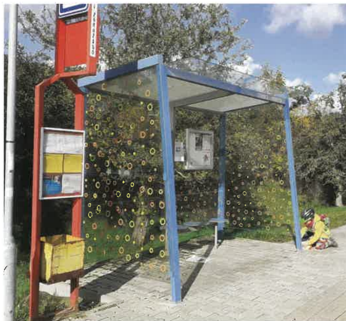
Takto vypadá efektivně zabezpečená zastávka. Nálepky jsou po celé ploše a zhruba 10 cm od sebe
